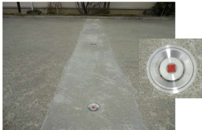
消雪、融雪工事
